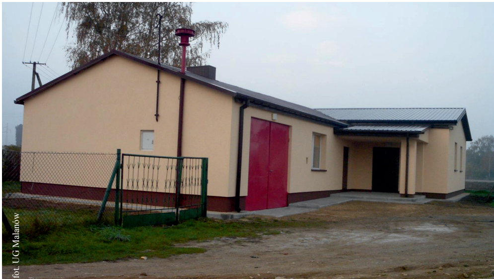
Nowa elewacji świetlicy
