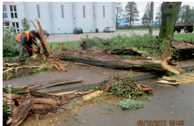
Porządkowanie ulic i chodników
