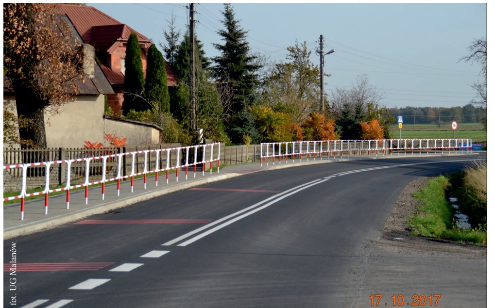
Odcinek wyremontowanej drogi
